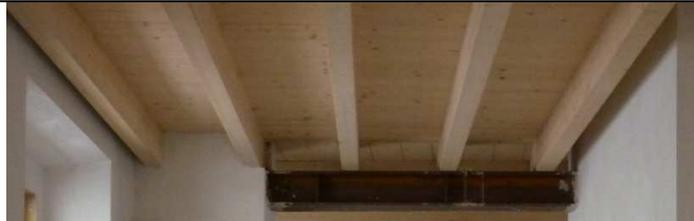
Tutti i solai sono stati realizzati in legno con cappa di c.a. collaborante.
