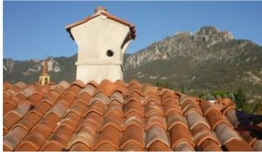
Il tetto di copertura è in travi di legno a vista in legno lamellare completato con assito, strato di barriera al vapore, doppi pannelli isolanti. Sopra i pannelli è stato posato un secondo assito in abete, telo impermeabile e listelli per la ventilazione naturale del tetto e per la posa delle tegole in laterizio, completato con colmo ventilato.
